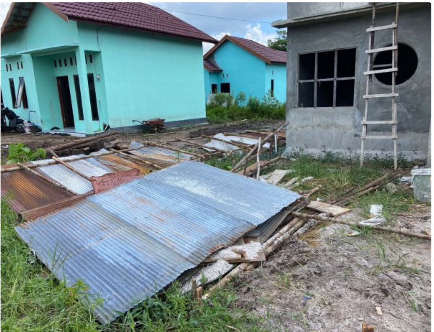
Gambar: Kondisi Pagar Seng Yang Dirusak Oknum
